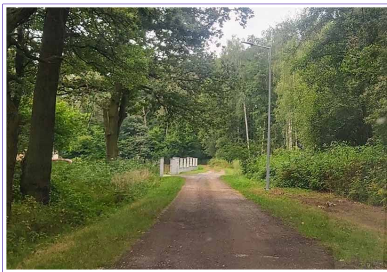
Oświetlenie drogi bocznej ul. M. Strzody
