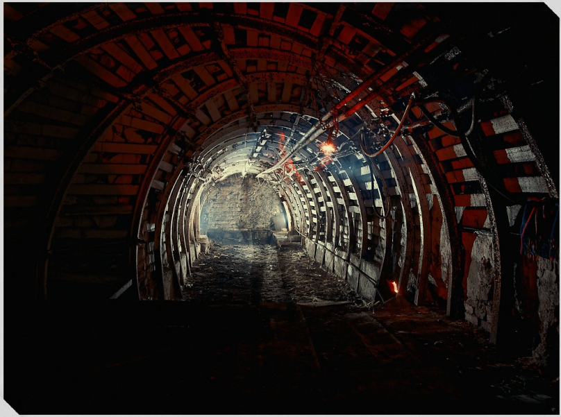
Sztolnia ćwiczebna na terenie przy szybie Leon III przejmowana przez Miasto Rydułtowy
