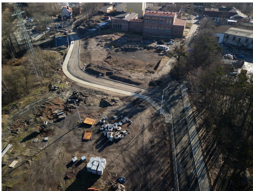
Budowa drogi łączącej centrum przesiadkowe z ul. A. Mickiewicza
