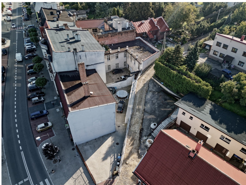
Przebudowa drogi łączącej ul. Skalną z ul. K. Przerwy - Tetmajera
