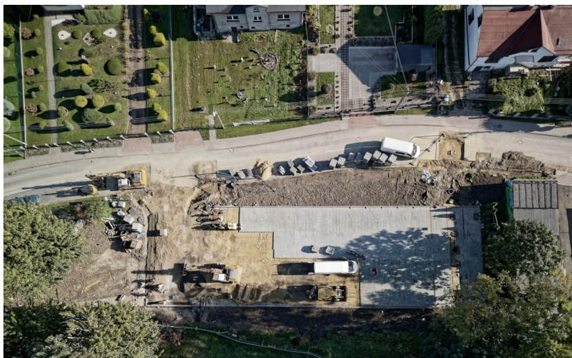
Budowa zabezpieczeń przeciwpowodziowych
