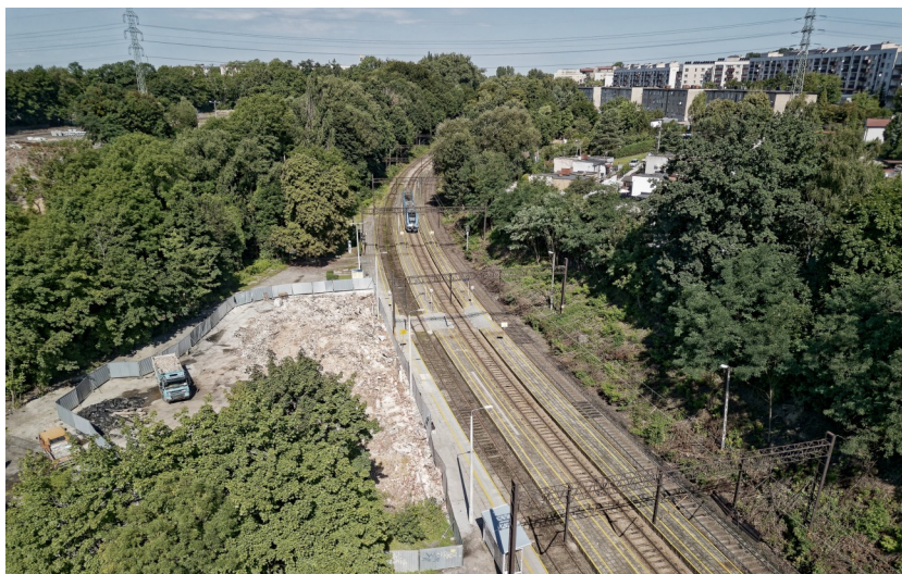
Budowa centrum przesiadkowego – etap I
